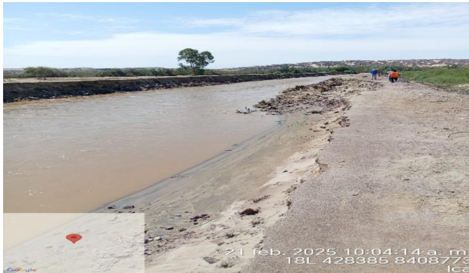
FIGURA N°03: EN LA TEMPORADA DE MAXIMAS AVENIDAS, EL RÍO ICA SOCABA ESTE TRAMO DEL SECTOR VIRGEN DE CHAPI, ARRASANDO CON LA VIA DE ACCESO AL LUGAR.
